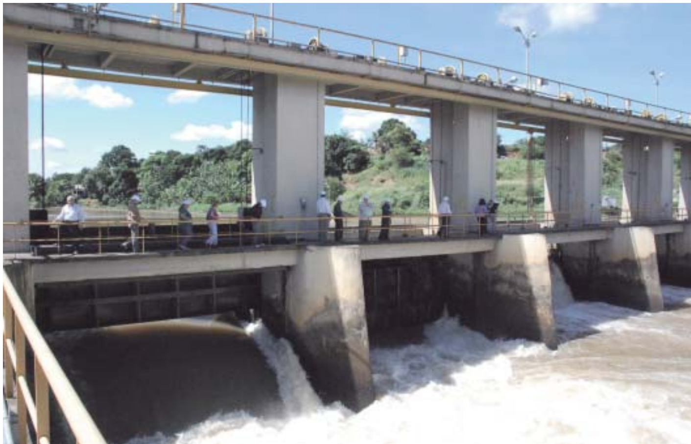
Barragem principal da Estação de Tratamento de Água do rio Guandu
